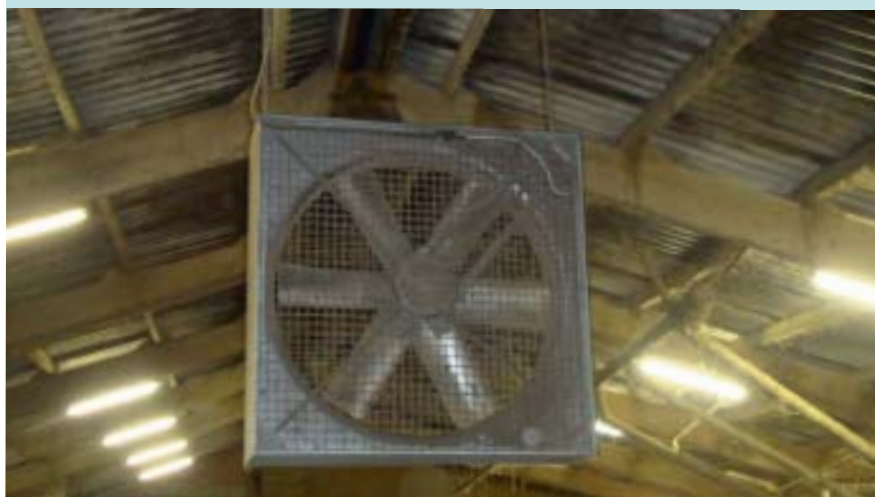
Axiaalventilatoren worden boven het voerhek geplaatst om de koe naar het voerhek te lokken.
